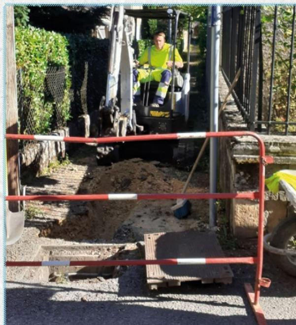
Dans le cadre des travaux préparatoires au renouvellement de la traverse de la RD 811, nous avons réalisé l'enfouissement du réseau électrique, la pose de fourreaux pour les télécoms, le renouvellement des réseaux d'eau potable et d'assainissement et la création d'un pluvial.
